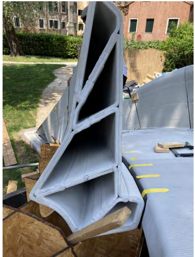
portes en compresión pura. Se utilizó el modelado de elementos discretos avanzado (DEM, por sus siglas en inglés), para refinar y optimizar la estereotomía de los bloques y comprobar la estabilidad del conjunto, en estados de carga extrema, o asentamientos diferenciales de los soportes.
