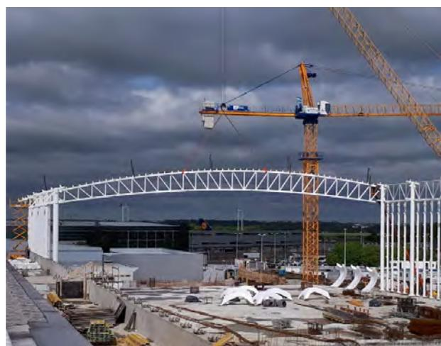
MONTAJE DE LAS VIGAS RETICULADAS DE ALTURA VARIABLE
