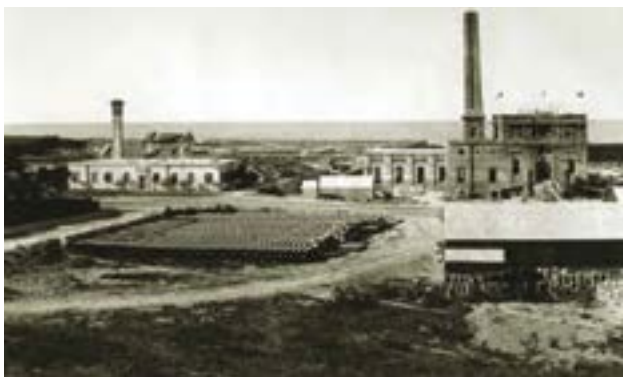
<<< LA PLANTA DE RECOLETA EN PLENA CONSTRUCCIÓN, 1875
