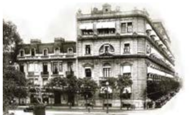
<<< VISTA EXTERIOR DE LA ADMINISTRACIÓN CENTRAL DE OBRAS SANITARIAS DE LA NACIÓN DESDE LA ESQUINA DE Av. CALLAO, 1935
