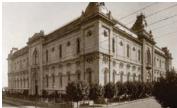
<<< VISTA DEL DEPÓSITO DE VILLA DEVOTO, 1919
