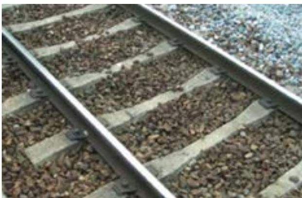
un arriostamiento efectivo en el plano horizontal para los durmientes, absorbiendo vibraciones y permitiendo el bateado mecanizado para recomponer la geometría de la vía.
