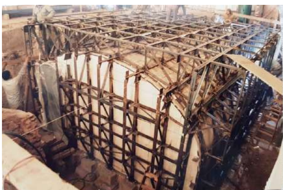
FIGURA 8 - AGREGADO DE LA ESTRUCTURA METÁLICA EXTERIOR
