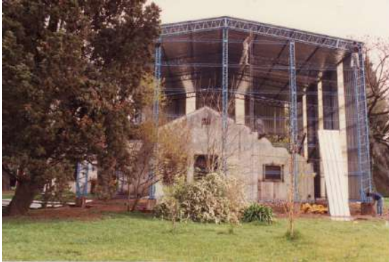
FIGURA 4 - CIMBRA EJECUTADA EN EL INTERIOR
