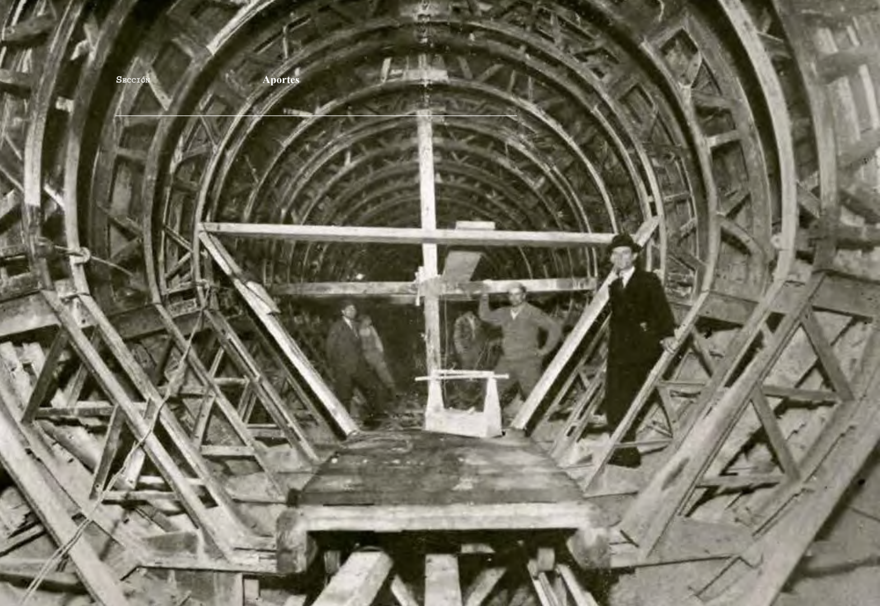
CONSTRUCCIÓN DE LOS RÍOS SUBTERRÁNEOS -CONDUCTOS DE ALIMENTACIÓN POR GRAVITACIÓN- DESDE LA PLANTA DE PALERMO HASTA LOS DEPÓSITOS DE AV. CÓRDOBA Y CABALLITO, 1943.
