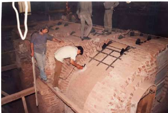
FIGURA 7A - DETALLE DE COLOCACIÓN DEL BASTIDOR
