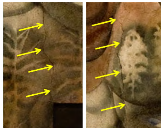
FIGURA 11 - FISURAS DE APARICIÓN POSTERIOR A LA EXTRACCIÓN
