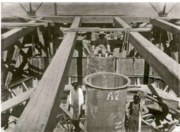
CONSTRUCCIÓN DE UN TÚNEL SUBLUVIAL DE PROVISIÓN DE AGUA EN LA CIUDAD DE BUENOS AIRES.
