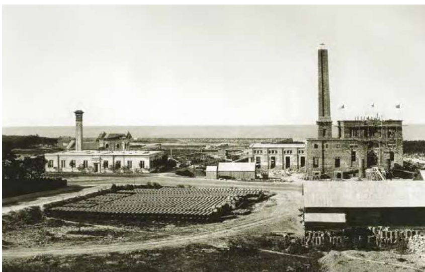
LA PLANTA DE RECOLETA EN PLENA CONSTRUCCIÓN.
