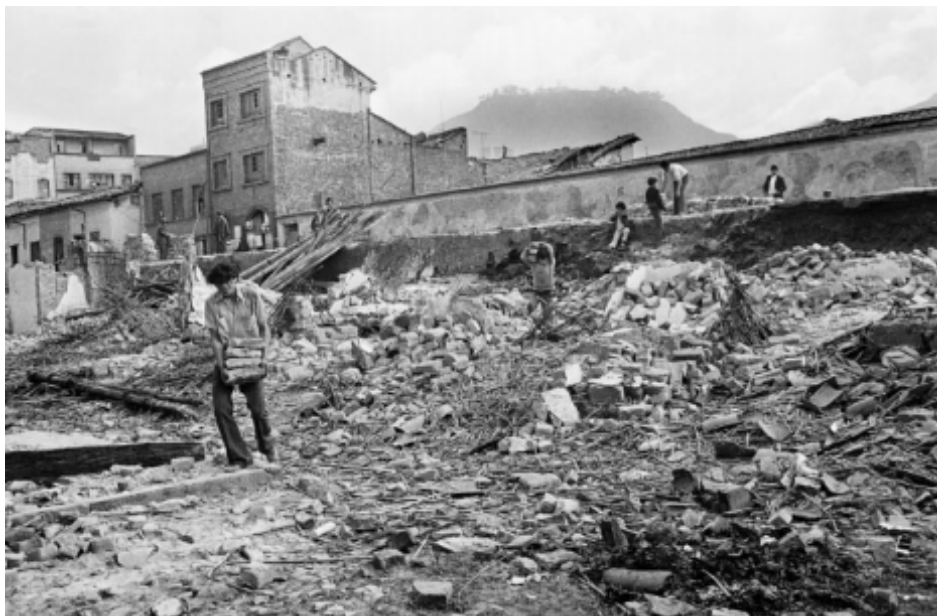
Imagen 1 Deterioro El Cartucho
