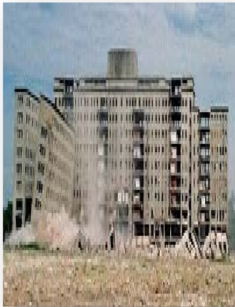
Demolición Albergue Warnes Foto: archivoteaydeportea.blogspot.com.ar
