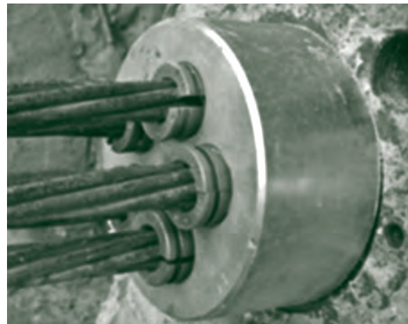
FIGURA 31. CABEZAL DE ANCLAJE DE CUATRO CORDONES
