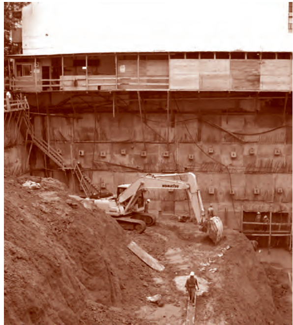
FIGURA I. ANCLAJES TEMPORARIOS. TORRE SALGUERO
