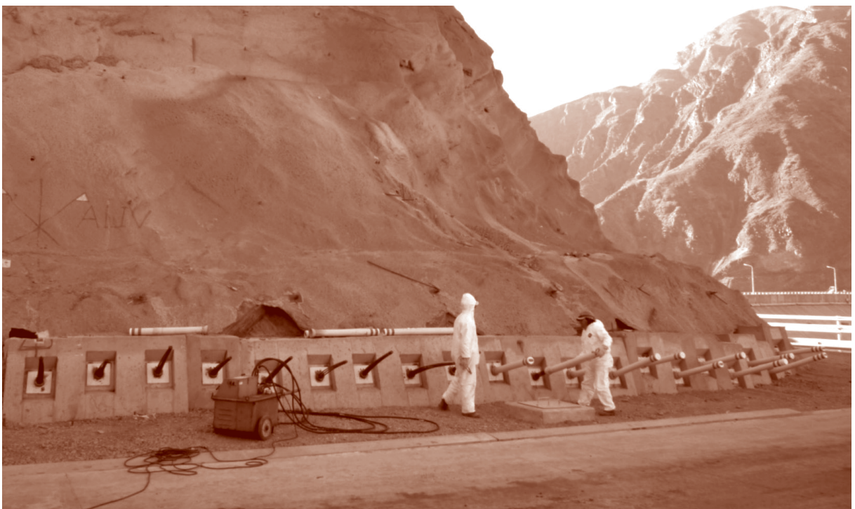
FIGURA 5. VISTA DE LOS ANCLAJES PERMANENTES DE LA PRESA CARACOLES
