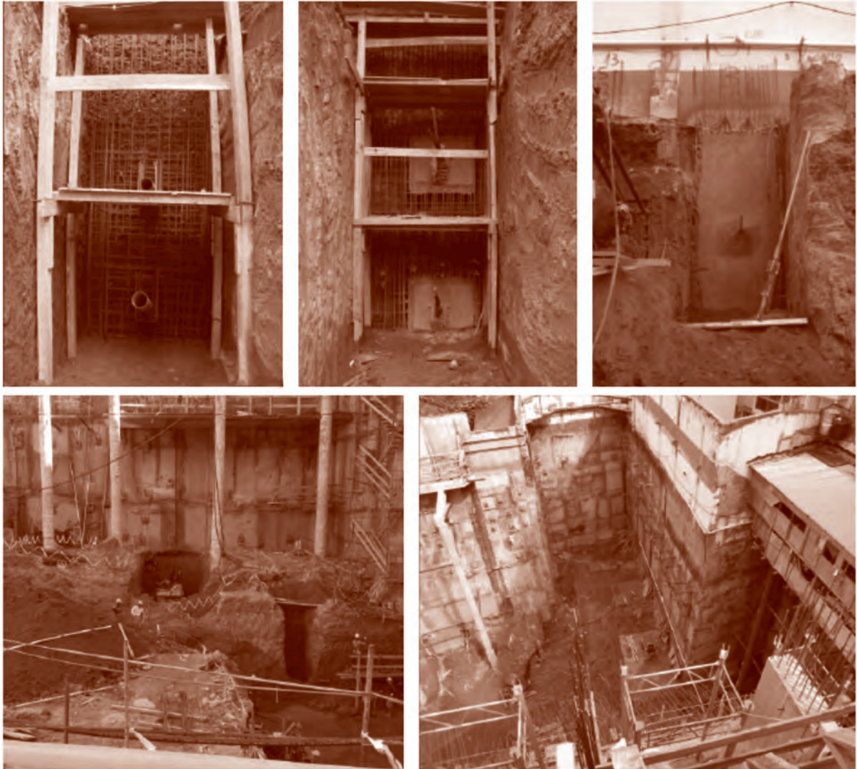
FIGURA 9. ETAPAS CONSTRUCTIVAS DEL MURO SOBRE LÍNEAS MEDIANERAS
