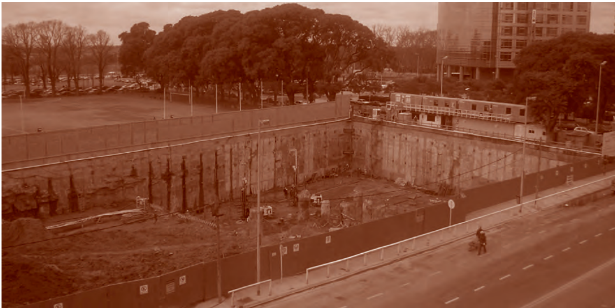
FIGURA I. ANCLAJES TEMPORARIOS. TORRE DEL YATCH. PUERTO MADERO, CABA
