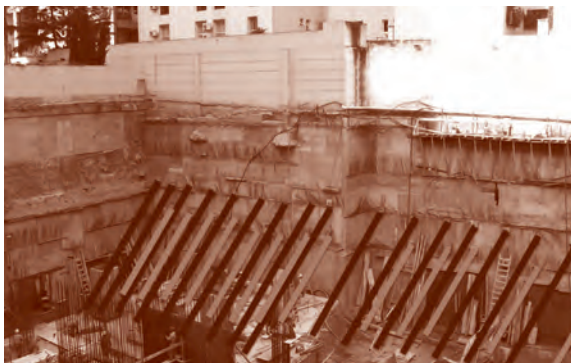
FIGURA 2. ¿CÓMO SERÍA LA OBRA SI NO SE PUDIERAN HACER LOS ANCLAJES AL TERRENO?
