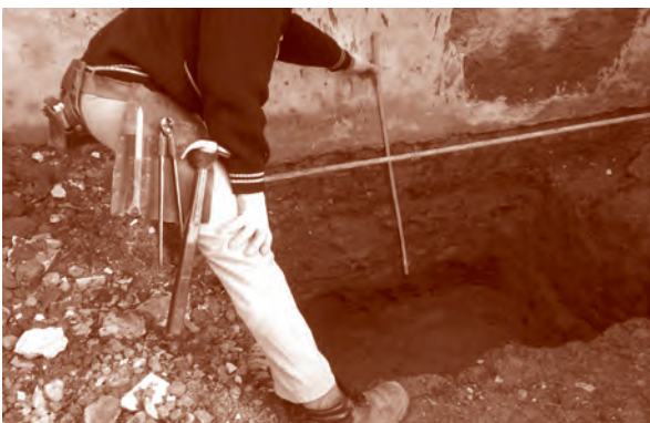
FIGURA 7. CALICATA PARA VERIFICAR FUNDACIÓN LINDERA
